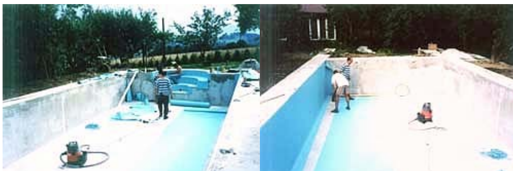
Wykładziny z PCV zbrojonego Alkorplan. Montaż przez DC ENGINEERING.
