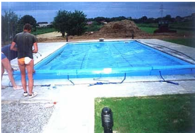
Basen odkryty w konstrukcji betonowej. Montaż pokrywy "słonecznej" typu pęcherzykowego.
